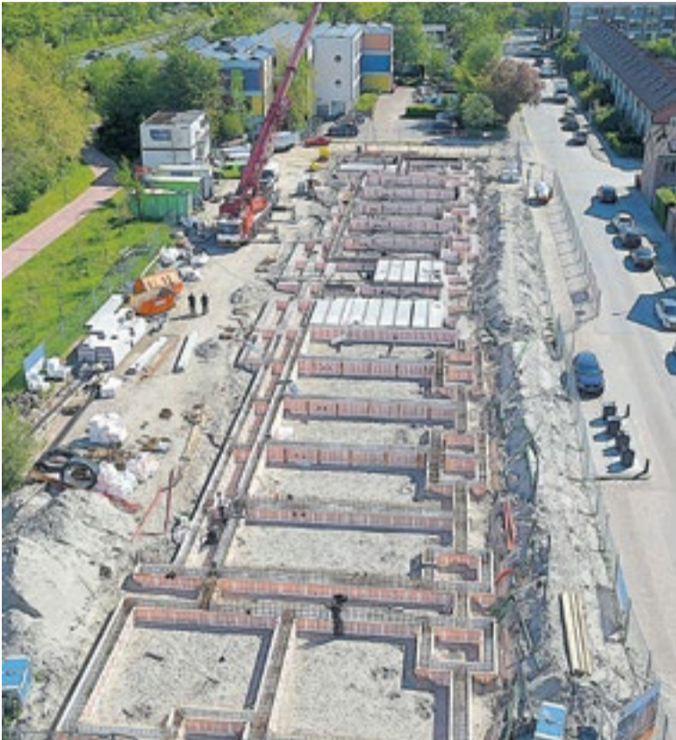
Overzicht in oostelijke richting, vloerdelen worden gelegd.
